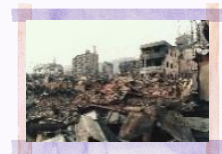
1995年1月 被災した街の様子 写真提供：神戸市
